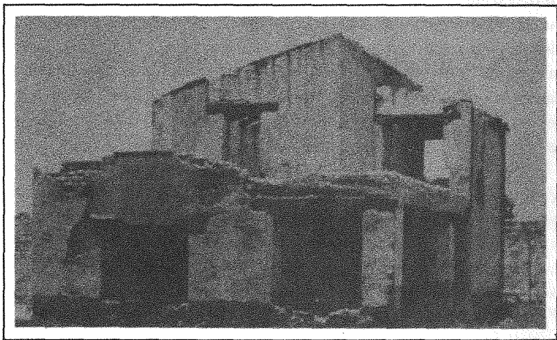
Casa natal de Felipe Villanueva, poco antes de ser demolida.
