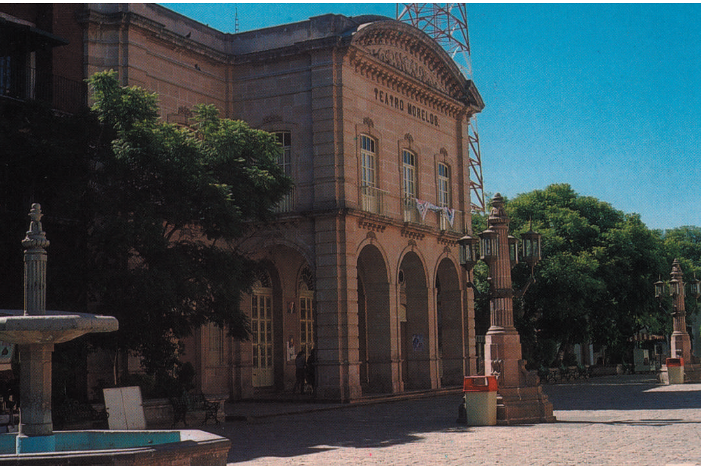
Aguascalientes. Teatro Morelos.
