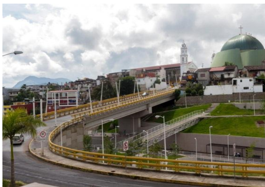
Foto 1. Nuevo puente que conecta la carretera México - Tuxpan con el centro, acervo personal 16- 05- 2015.
