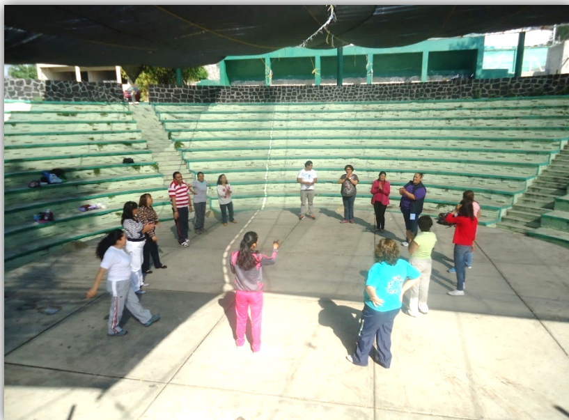
Figura. 3. [Fotografía, Espacio abierto en donde se realizan las sesiones prácticas, se puede notar las escalinatas con capacidad para mil personas, el escenario tiene forma semicircular.] (Naucalpan, Estado de México 2015). Registro fotográfico del servicio social. Centro de Maestros Naucalpan 2.
