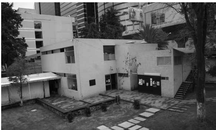
Nuevas instalaciones de la END (cuatro salones) dentro del predio de Campos Elíseos construidos a finales de los años setenta. Posteriormente se hizo el pequeño edificio de dos pisos a la derecha, así como el salón de danza cubierto por una lona que aparece a la izquierda . Fotógrafo: Guillermo Israel González Sánchez
