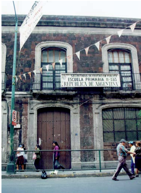
Aspecto parcial de la fachada del local que ocupara temporalmente el Conservatorio en la calle de Puente Leguizamo 68, hoy con el nombre de Argentina.
