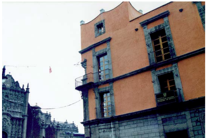
Vista lateral de los altos del edificio de la Ex-Universidad que fueran concedidos por el Presidente Juárez al Conservatorio de la Sociedad Filarmónica.
